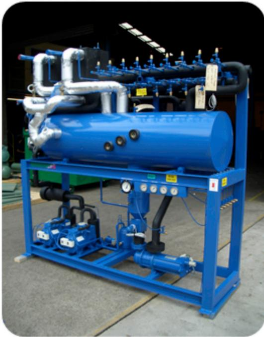
Figura 14: Rack subcrítico con CO<sub>2</sub> combinado, DX-LT e Recirc.-MT
