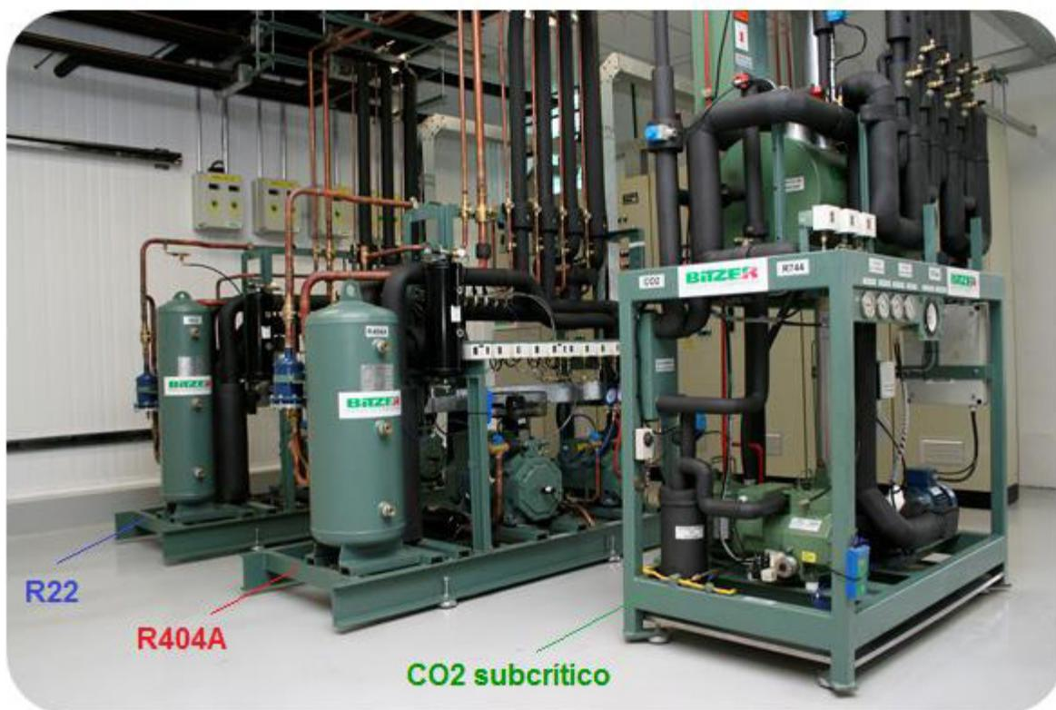
Figura 19: Detalle de los equipos evaluados energéticamente
