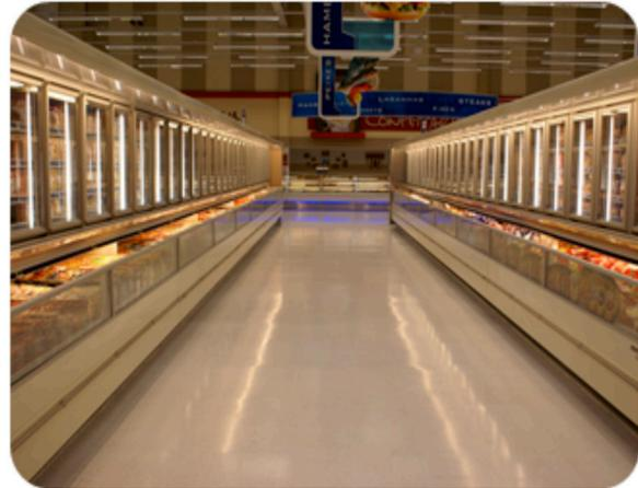
Figura 12: Expositor e islas de baja temperatura que operan con CO<sub>2</sub>
