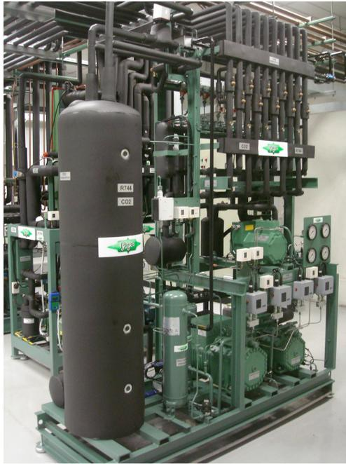
Figura 6: Rack de CO<sub>2</sub> transcrito instalado en Brasil
