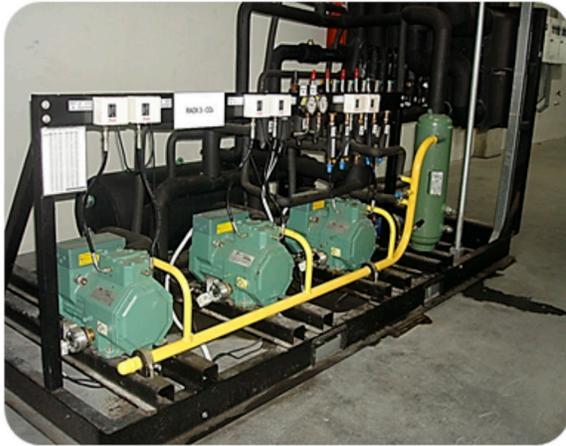
Figura 11: Rack subcrítico con CO<sub>2</sub>, condensación hecha con glicol
